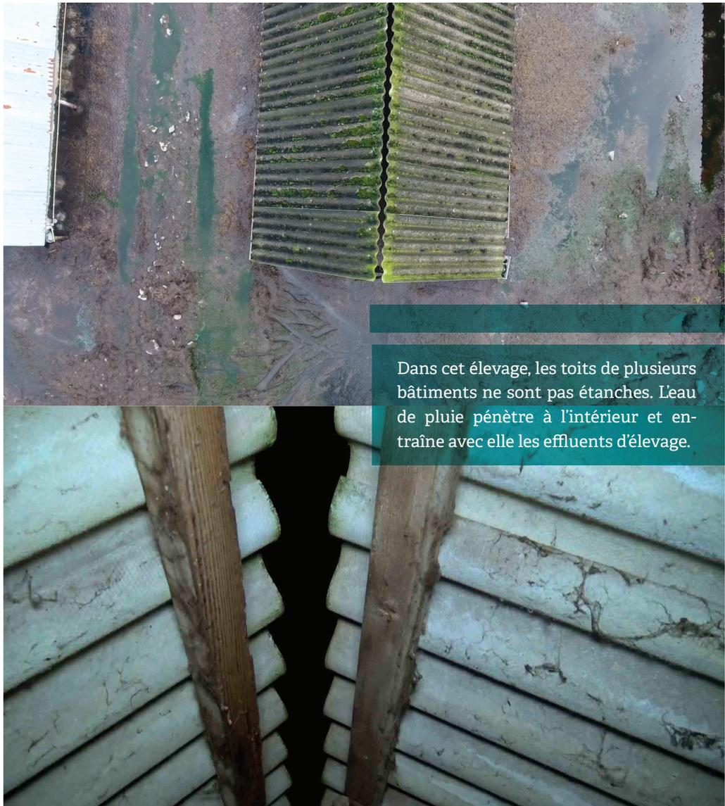
Dans cet élevage, les toits de plusieurs bâtiments ne sont pas étanches. L'eau de pluie pénètre à l'intérieur et entraîne avec elle les effluents d'élevage.
